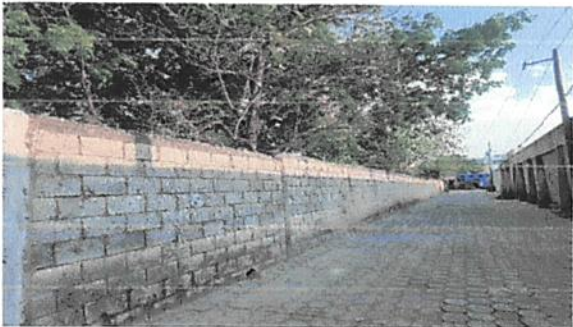
FOTO 3: se levantará y se reforzará el muro perimetral
