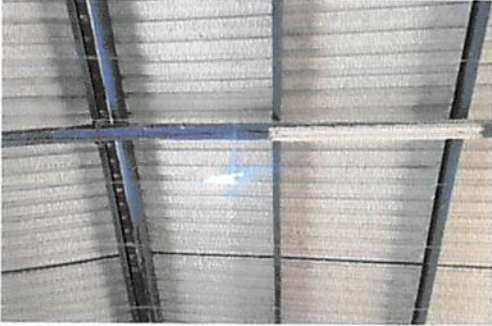
FOTO1: SE REALIZARÁ EL CAMBIO DE UNA LAMINA EN AULA
